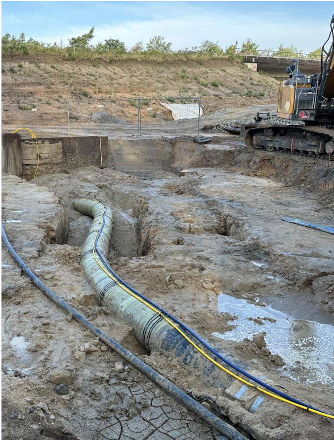
Befestigung L+P Mess-Schlauch und Temperaturmess-Leerrohr
