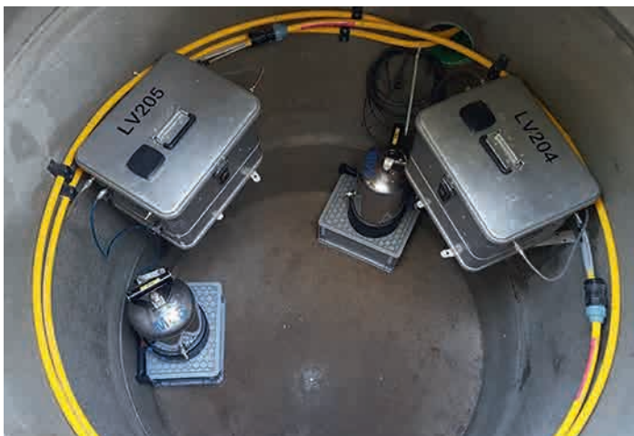
Abb. 4 Der Anschlusspunkt für die Messgeräte befindet sich in einem Schacht neben dem Einstiegbauwerk, am Messleitungsende.
